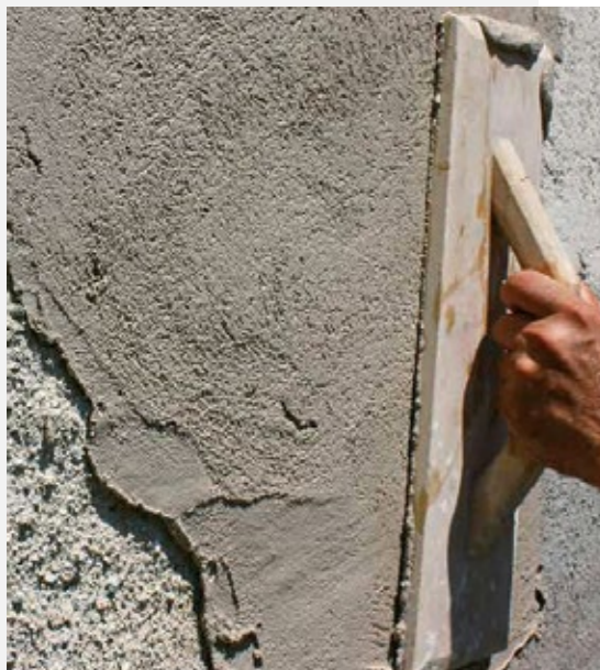
Il caratteristico effetto rustico può essere ottenuto utilizzando rasanti con granulometria maggiorata
