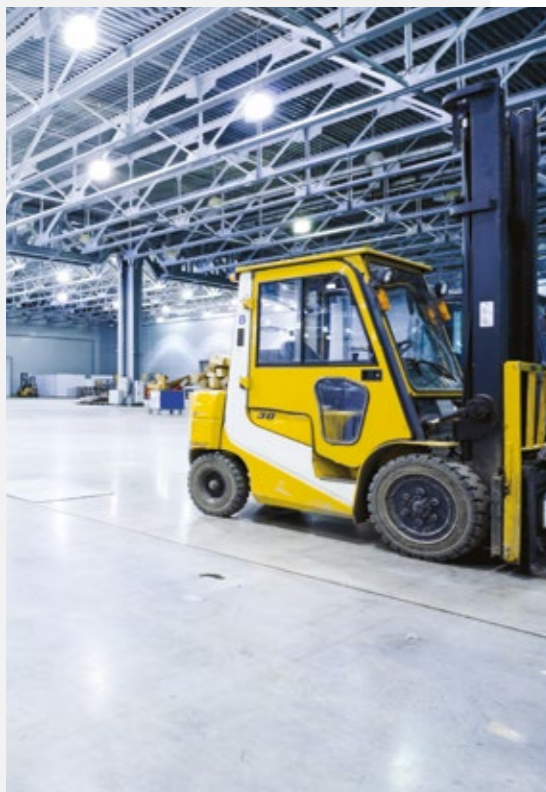
Le sollecitazioni meccaniche possono mettere a dura prova il massetto e l'intero sistema flooring.
