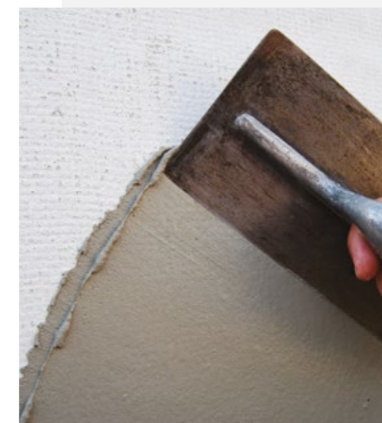
Rasatura su pannello di fibrocemento
