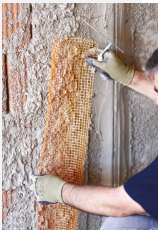
Posizionare una rete in corrispondenza dei giunti agevola l’adesione dell’intonaco
