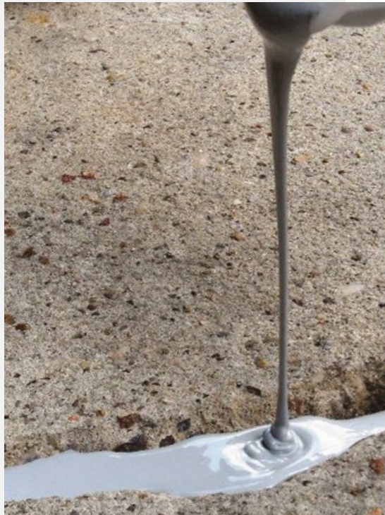
La superficie di posa dev'essere integra. Eventuali fessurazioni possono essere colmate con materiali di natura organica.
