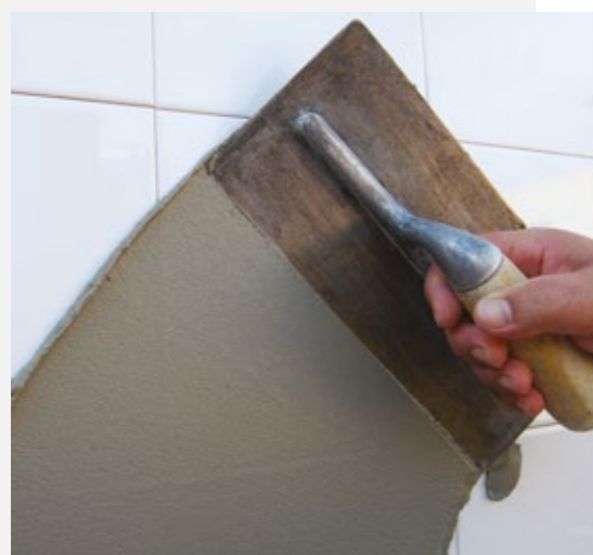
Rasatura su vecchi rivestimenti ceramici
