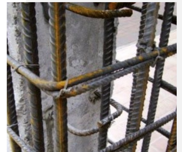
Dettaglio dell'armatura di un pilastro
