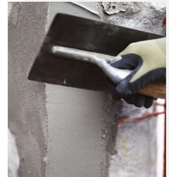
La protezione di elementi in calcestruzzo presuppone l'utilizzo di prodotti certificati
