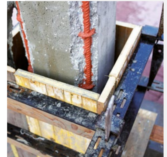
I casseri devono essere resistenti e saldamente ancorati per evitare perdite di materiale
