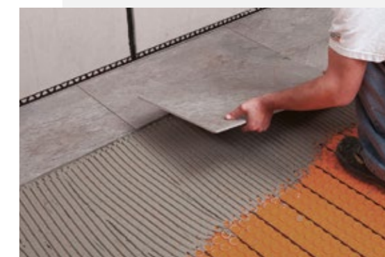
Tradicol MC2 è il collante giusto anche per la posa su massetti radianti
