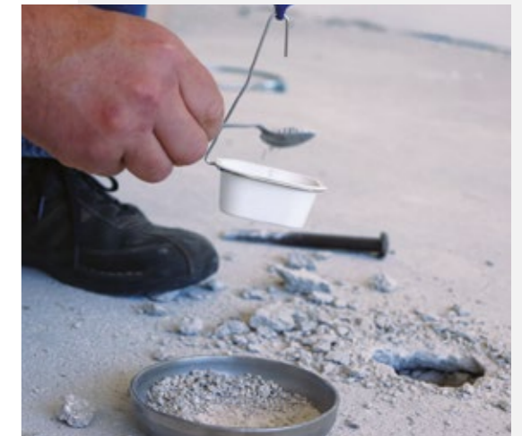
Un buon sottofondo deve presentarsi asciutto. La misurazione dell'umidità residua è effettuata mediante igrometro a carburi
