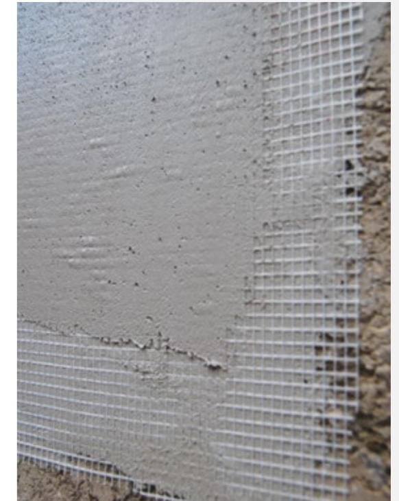
La rasatura armata garantisce una maggiore durevolezza del lavoro
