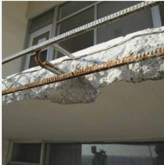
Nel ripristino di sottobalconi gravemente ammalorati può essere opportuno utilizzare malte colabili.
