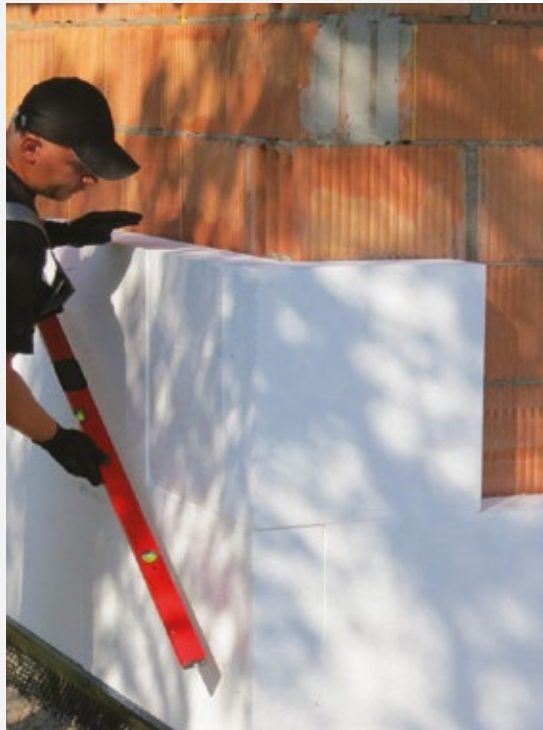
Applicazione di pannelli da cappotto in polistirene
