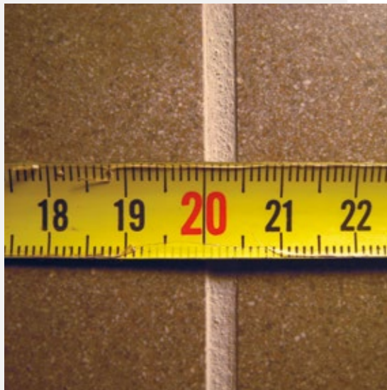
Per favorire la deformabilità del rivestimento è opportuno prevedere una fuga di almeno 2 mm
